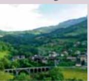
Le viaduc de Mieussy, construit en 1931, mesure 126m de long et comporte une arche centrale de 24 mètres d'ouverture dominant le Foron de 20 mètres. Il permettait le passage d'un train reliant Annemasse à Sixt.
